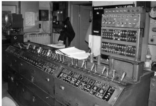
Abbildung 3: elektromechanisches Stellwerk
